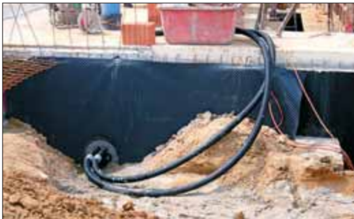
Im Neubaugebiet südlich der Richard-Wagner-Straße wurden die ersten Anschlüsse verlegt, um hier künftig mit Fernwärme zu heizen.
